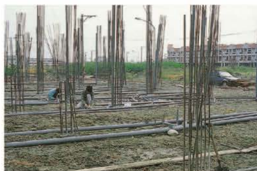
▲建筑工程 Construction engineering
