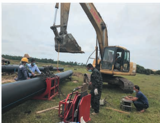
▲ 海南PE管自来水工程
