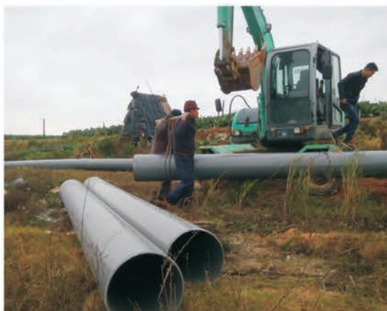
▲ 厦门同安农村饮水工程
